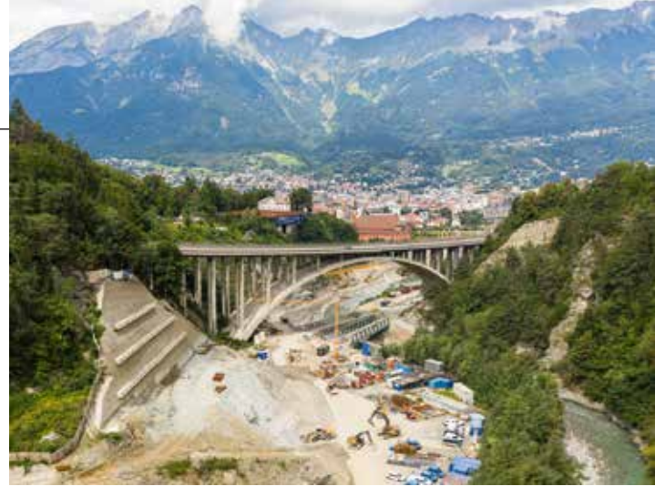
Im Zuge der Fertigstellung des BBT gibt es viel zu tun – wie hier Hangabtragungsarbeiten am Bergisel für den Bau des Vortunnels „Silltal“.
