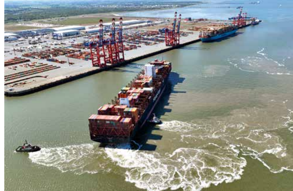
Da immer mehr Großcontainerschiffe Wilhelmshaven anlaufen, werden die bestehenden acht Containerbrücken nun um elf Meter erhöht.
