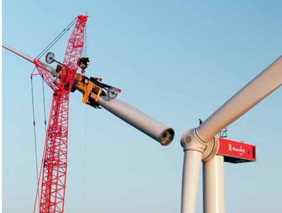
Bei der Rotorblattmontage kommt ein neues Hebemittel zum Einsatz, das die Rotorblätter greift und während des Installationsvorgangs mithilfe zweier Propeller automatisch in Position hält.
