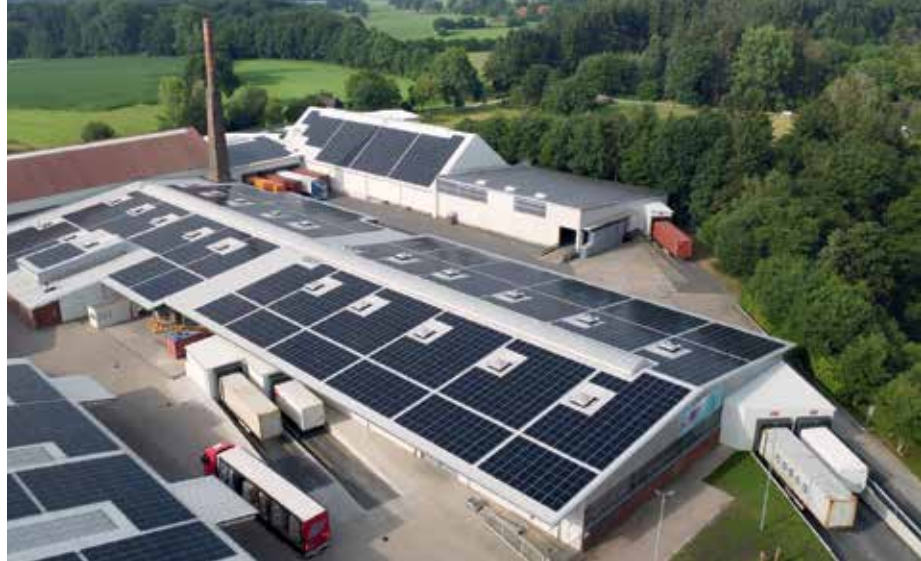
Dank einer großflächigen Fünf-Megawatt-Photovoltaikanlage auf den Dächern ist die nachhaltige Ausrichtung von Albers Logistik auch aus der Luft zu erkennen.
